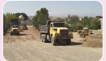
عملیات خاکبرداری و زیرسازی پروژه خیابان امامزاده سید احمد (ع)
