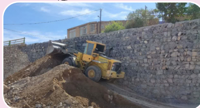
عملیات بازسازی دیوار تخریب شده خیابان بهار، محله کله مسیح
