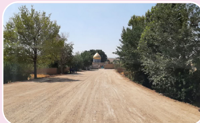
عملیات خاکبرداری و زیرسازی پروژه خیابان امامزاده سید احمد (ع)
