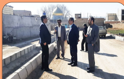
• بازدید از روند اجرای پروژه خیابان امامزاده سید احمد(ع)
