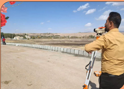
عملیات دیوار کشی، پیاده رو سازی و جدول گذاری خیابان بهار محله کله مسیح
