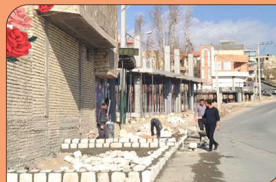
عملیات سنگ چین و پیاده روسازی بلوار زاینده رود
