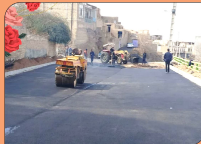
آسفالت خیابان بهار محله کله مسیح
