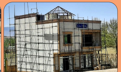
• روند اجرای مهمانسرای شهرداری زاینده رود
