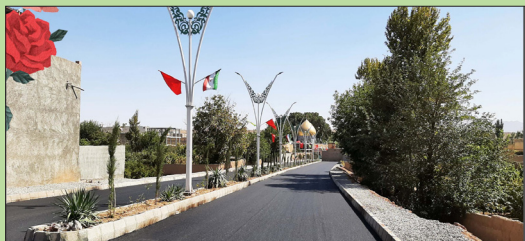
آزاد سازی، زیر سازی، جدول گذاری، اجرای روشنایی، فضای سبز و آسفالت خیابان امامزاده سید احمد (ع)
