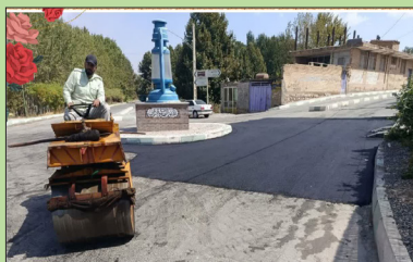
ترمیم ترانше ها، لکه گیری و آسفالت معابر سطح شهر
