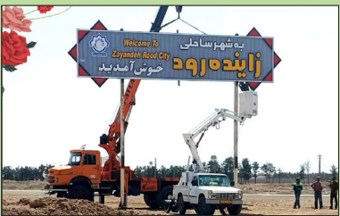
نصب تابلو خوش آمدید و پرچم مقدس جمهوری اسلامی، ورودی شهر از سمت مسکن مهر
